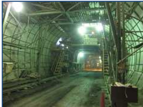
状況写真 トンネル内 覆工コンクリート完了
